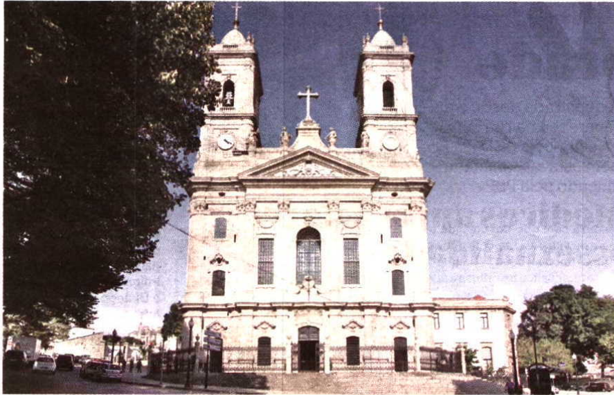
Reabilitação do monumento histórico encontra-se em fase de conclusão
